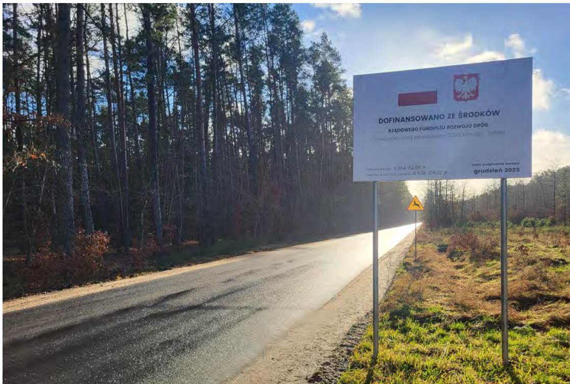
Zdjęcie 24. Droga powiatowa nr 2233Z po przebudowie
