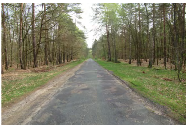
Zdjęcie 16. Droga Bogdanka-Sitnica przed przebudową
