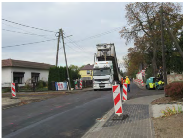
Zdjęcie 26. Droga w trakcie remontu
