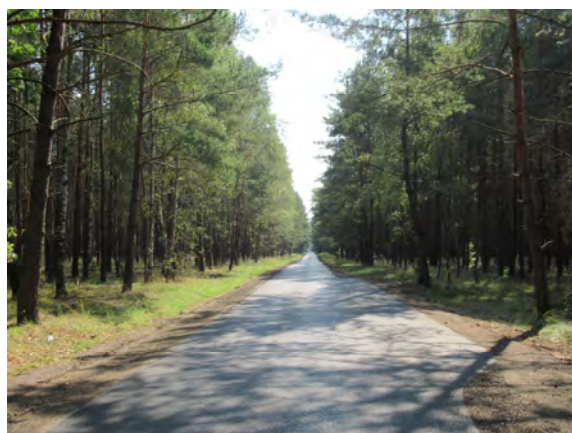
Zdjęcie 17. Droga Bogdanka-Sitnica po przebudowie
