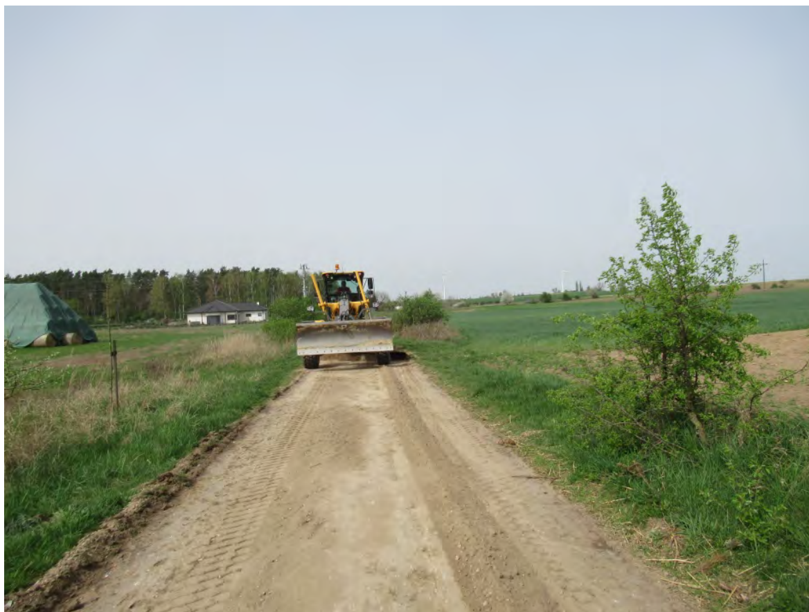
Zdjęcie 29. Profilowanie drogi
