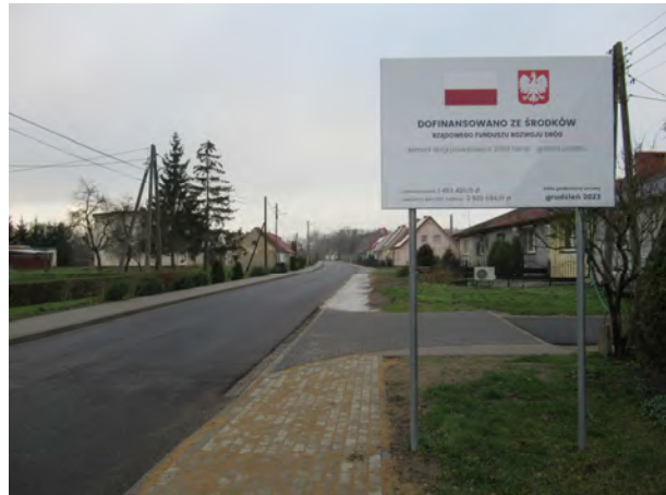
Zdjęcie 27. Droga po remoncie
