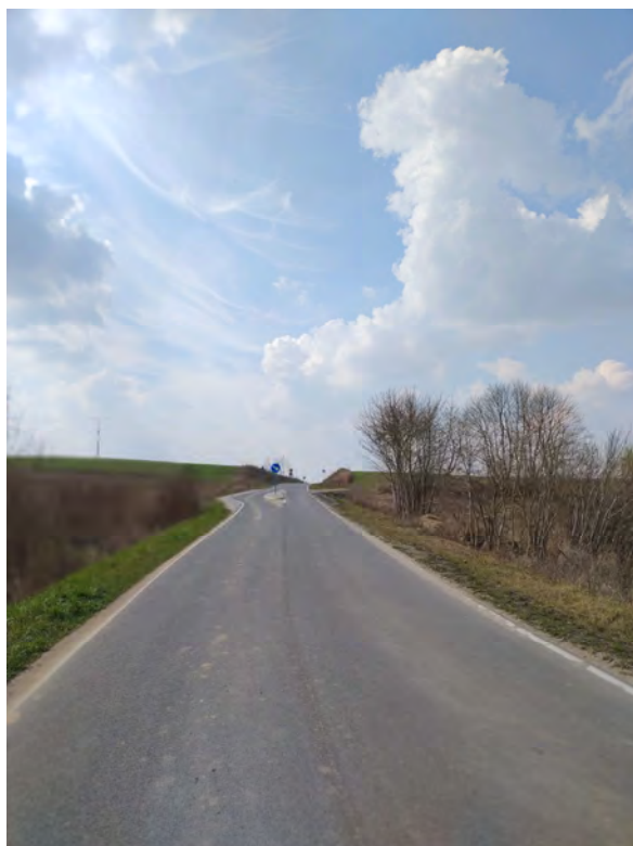
Zdjęcie 19. Droga powiatowa Słonice - Rakowo po przebudowie
