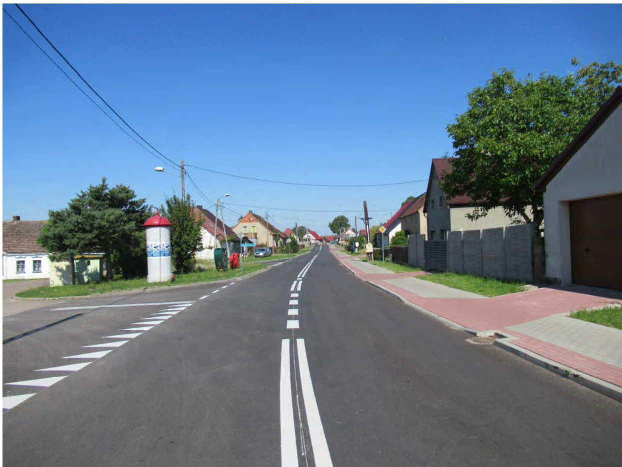
Zdjęcie 25. Droga powiatowa w miejscowości Chłopowo
