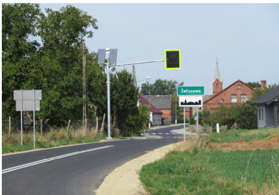
Zdjęcie 18. Droga Recz-Żeliszewo po przebudowie
