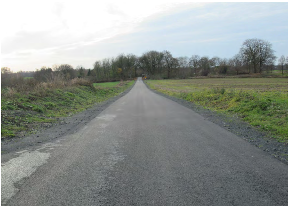
Zdjęcie 21. Przebudowana droga powiatowa nr 2222Z
