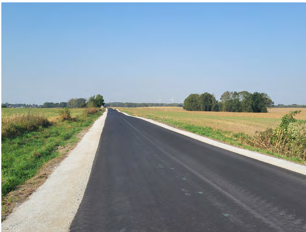
Zdjęcie 28. Droga powiatowa nr 2206Z Choszczno – Gleżno po remoncie
