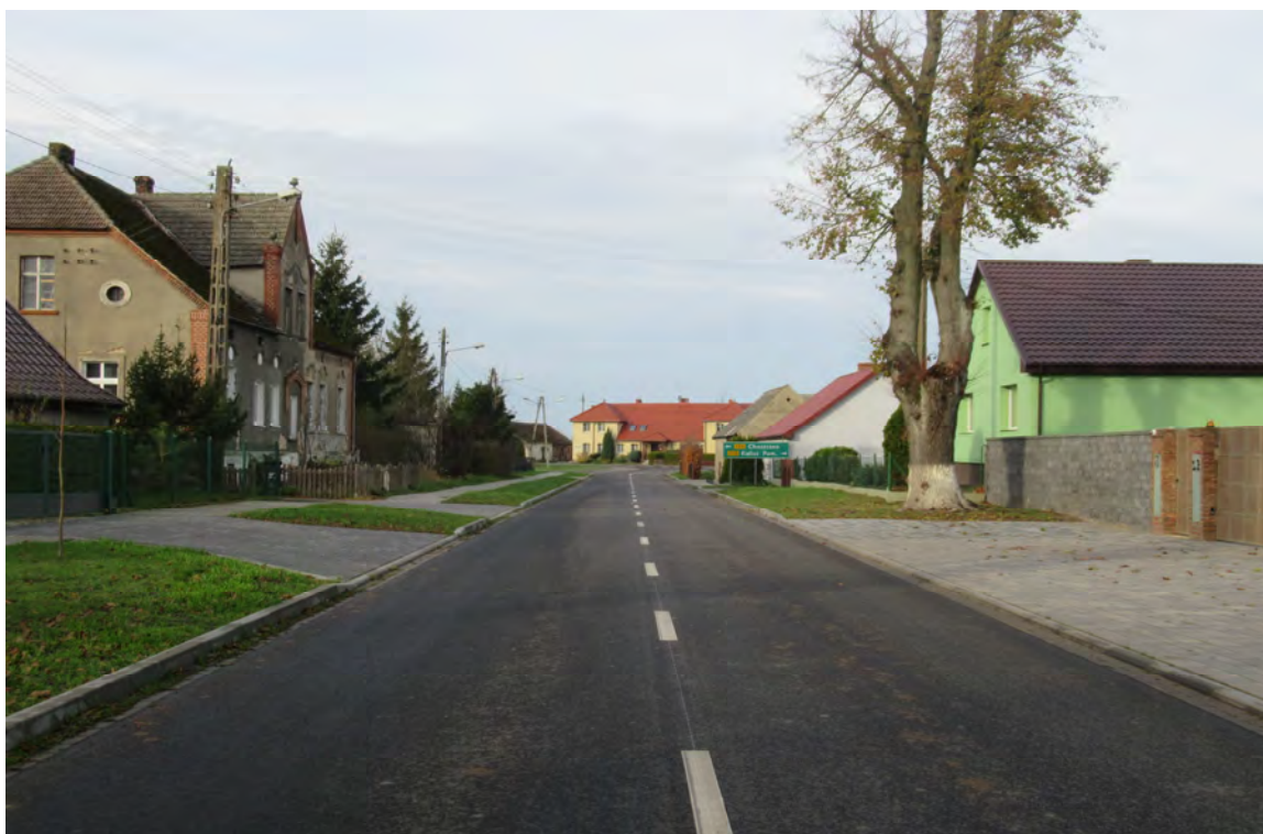
Zdjęcie 22. Przebudowana ul. Zwycięstwa w miejscowości Suliszewo
