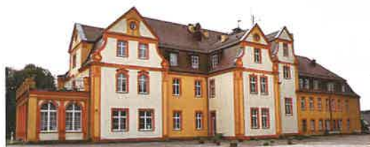
Fotografia 20. Widok na pałac w Brzezinach Źródło: Zbiory Starostwa Powiatowego w Choszcznie
