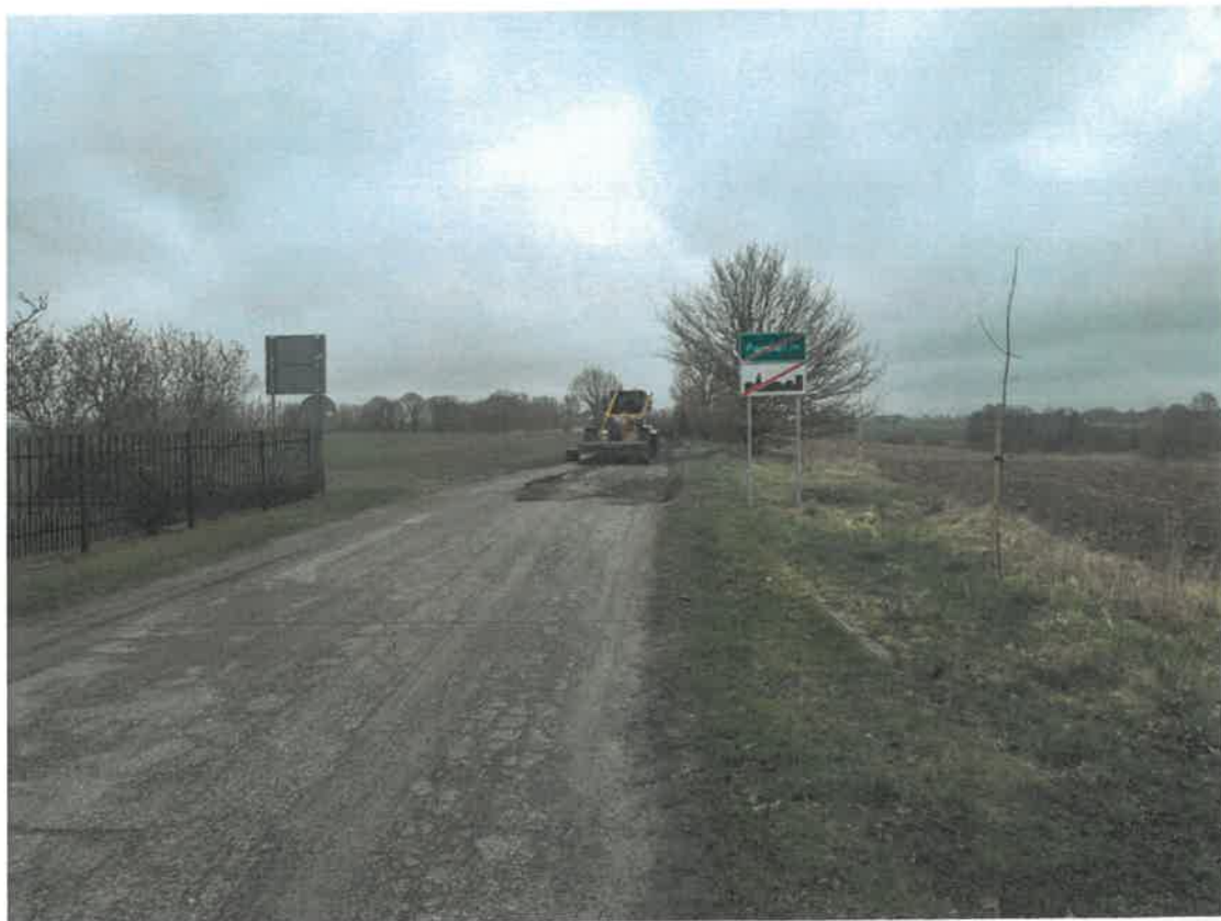
Profilowanie dróg równiarką z zagęszczeniem walcem drogowym
