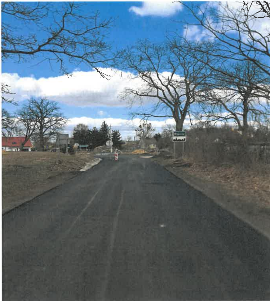
W trakcie przebudowy
