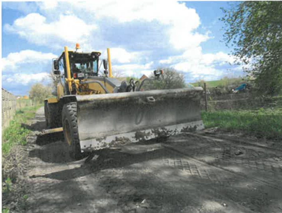
Profilowanie dróg równiarką z zagęszczeniem walcem drogowym
